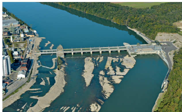
Centrale hydroélectrique de Rheinfelden.
