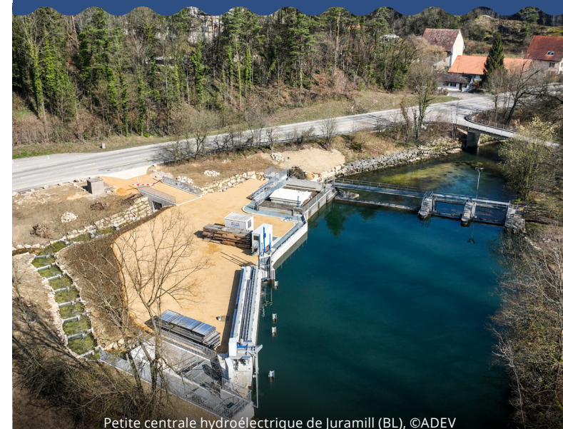
Petite centrale hydroélectrique de Juramill (BL), ©ADEV
