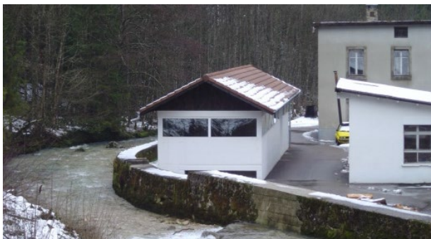
Kraftwerksgebäude Blanches-Fontaines in Undervelier
