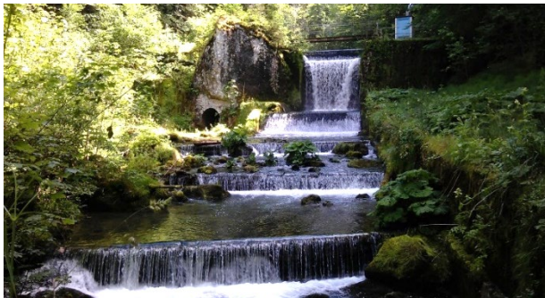
Staumauer des Kleinwasserkraftwerks Blanches-Fontaines in Undervelier (JU)
