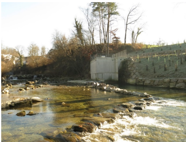
Kraftwerksgebäude mit Unterwasserkanal
