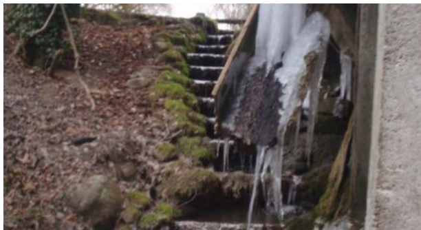
Fischaufstiegshilfe beim 2. Wasserrad (Foto Januar 2017, mhylab)
