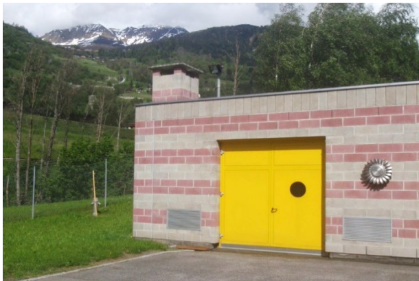
Zentralgebäude, mit dem alten Turbinenrad ( Q_n = 240 \text{ l/s} ). Im Hintergrund Verbier und der Verlauf der Druckleitung. Quelle: Mhylab
