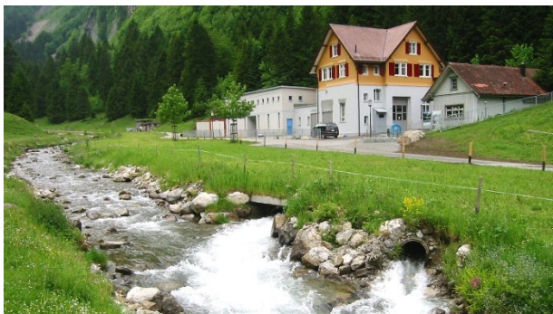
Maschinenhaus und Wasserrückgabe
