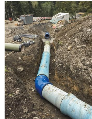
Herausfordernde Bauarbeiten im steilen Gelände
