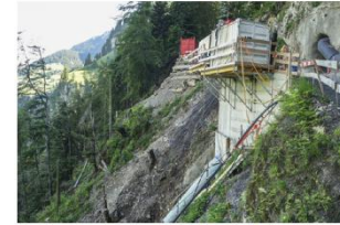
Reaktorinstallation in schwindelnder Höhe
