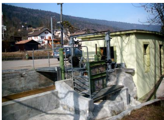
Das reaktivierte Pico-Kraftwerk Cormoret im Jura (Foto:Revita)
