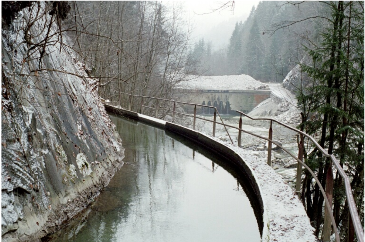
Das Kleinwasserkraftwerk Entlen (193 kW) wurde im Zusammenhang mit dem Biosphärenreservat Entlebuch mit Sonderkrediten des Bundes für erneuerbare Energien gefördert. Sein Oberwasserkanal ist ein industriegewerbliches Bijou.
