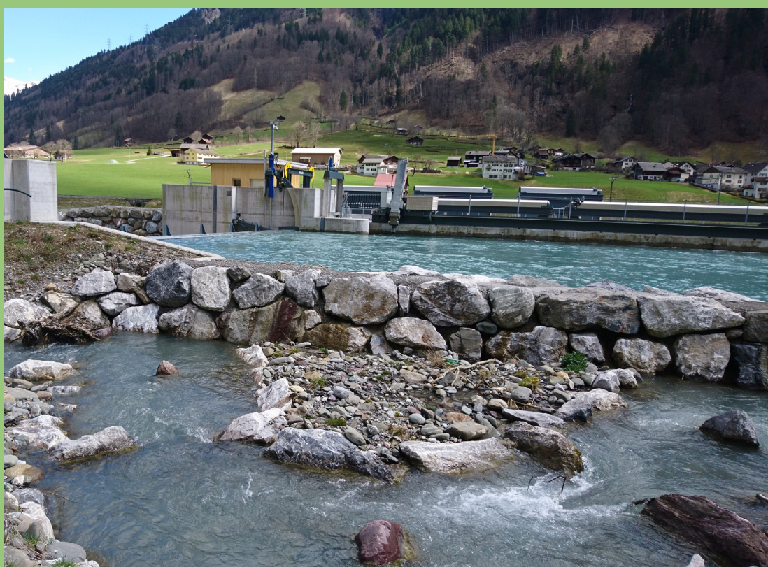
Bras de contournement naturel d'une petite centrale hydroélectrique sur la Linth, dans le canton de Glaris.
