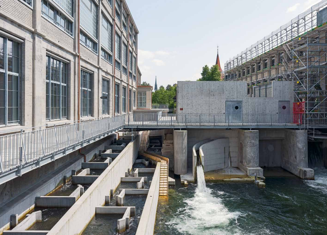
Kleinwasserkraftwerk «Papieri Cham» (ZG), ©Cham Group
