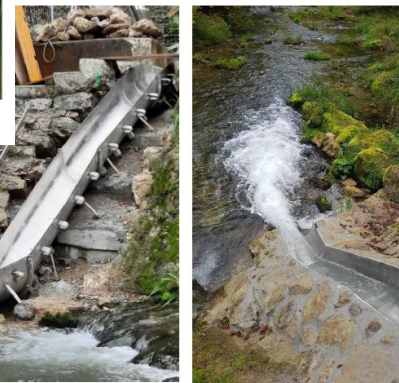
Figure 16 Vue du toboggan de dévalaison en construction à gauche et en service à droite. Source : EnEn, 2022, 2023.
