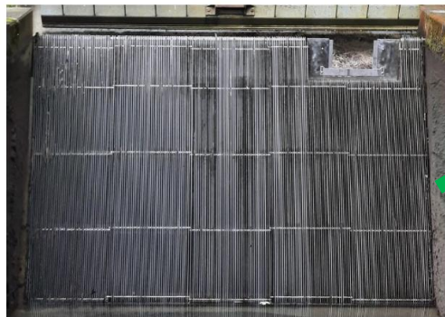
Figure 14 Vue du plan de grille avec l'échancrure en bout à droite et en médillon. Source : EnEn 2024.
