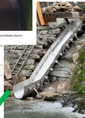
Figure 16 Vue du toboggan de dévalaison en construction à gauche et en service à droite. Source : EnEn, 2022, 2023.
